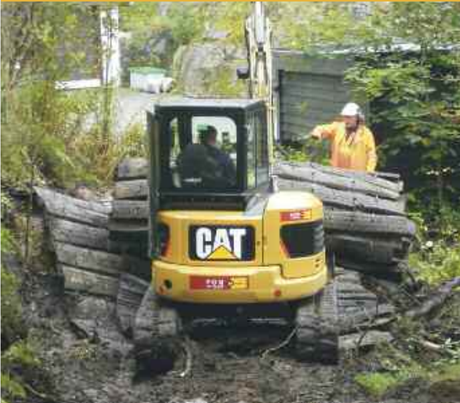
Minigraveren Cat 305.5D CR løfter skytemattene etter sprengning i den nye naturstien i Hellefjellet.
