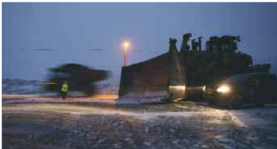
Skjæret på D11R-dozeren er åtte ganger tre meter med kapasitet på 75 m 3 .
